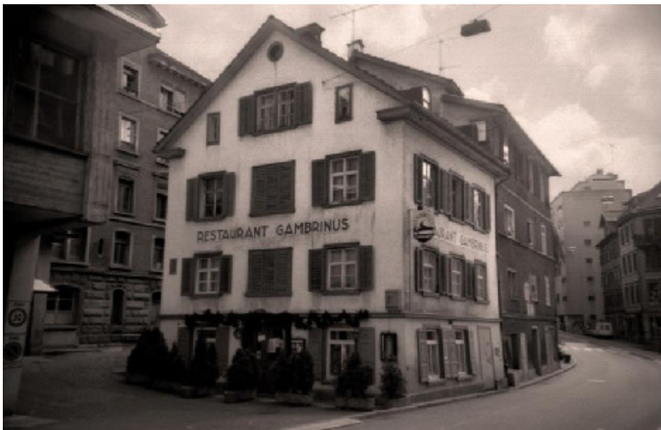
Ehem. Rest. Gambrinus, Wassergasse 5, 9000 St. Gallen
